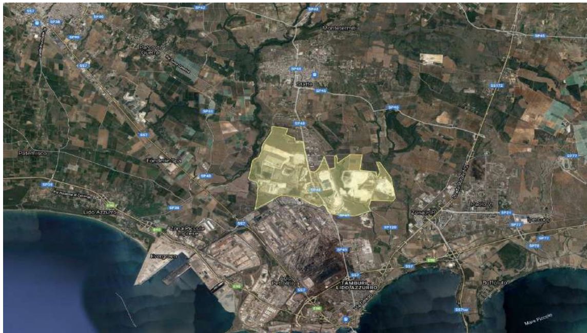
Area di prelievo del materiale calcareo da parte della Ex ILVA per la produzione dell'acciaio per un'estensione di 8,42 Km 2
