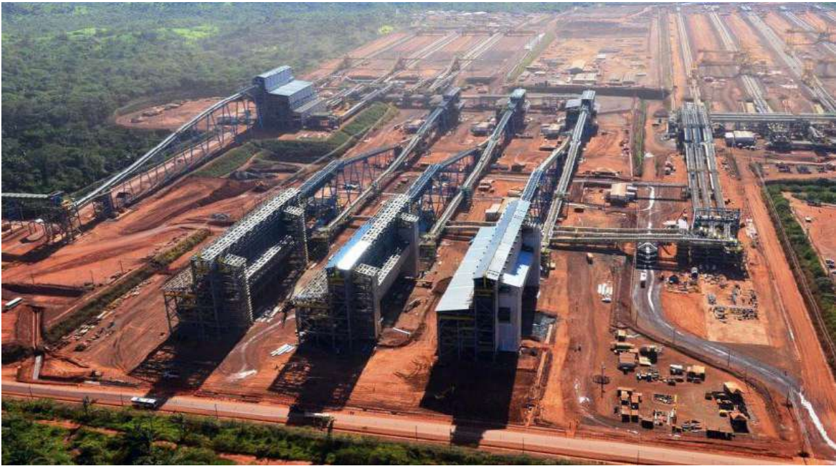
Impianto di frantumazione minerale di ferro Canaã dos Carajás Vale S.a.
