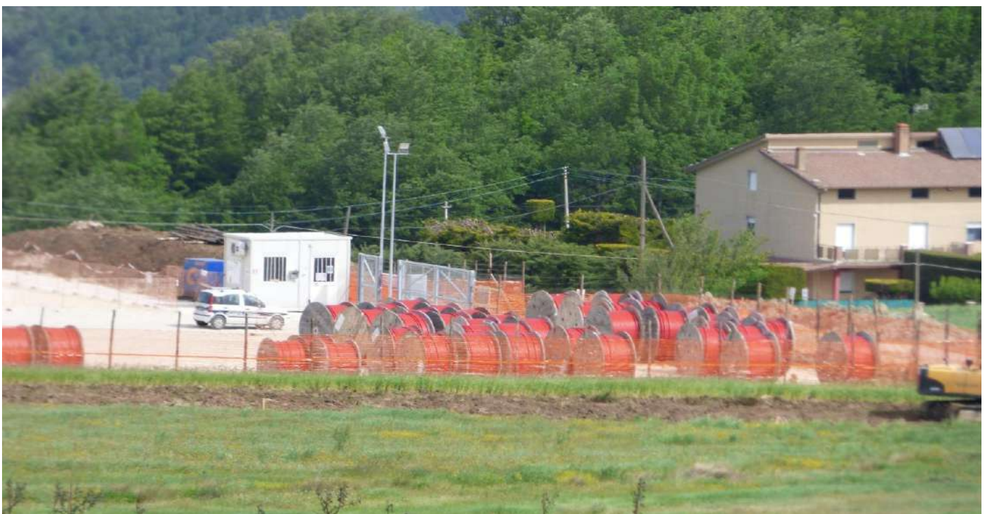
Giugno 2021 Baselice (BN) Rotoli di cavi di rame per costruzione dei cavidotti
